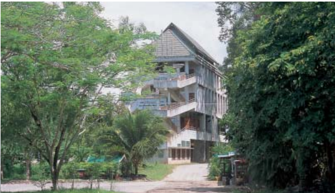
อาคารคณะธรรมทาน ตั้งอยู่หน้าประตูด้านทิศใต้ของวัดธารน้ำไหล
