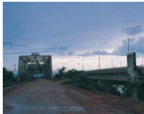
สะพานพระจุลจอมเกล้าที่อยู่ข้ามมือเป็นสะพานเก่าที่สร้างขึ้นใช้ข้ามแม่น้ำตาปี ปัจจุบันนี้มีสะพานใหม่ที่อยู่ทางขวามือใช้แทนของเก่า
