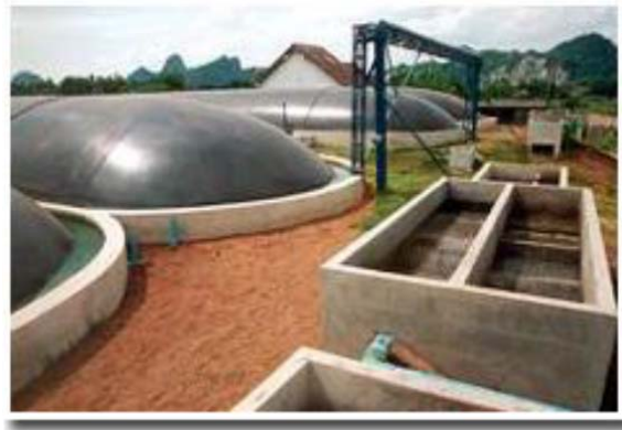
รูปที่ 14-2 แสดงบ่อหมักก๊าซชีวภาพที่ได้รับการปรับปรุงคุณภาพ
