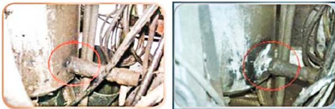
รูปที่ 2-29 รูปแสดงตัวอย่างบริเวณที่มีการรั่วไหลของอากาศอัดก่อนและหลังปรับปรุง
