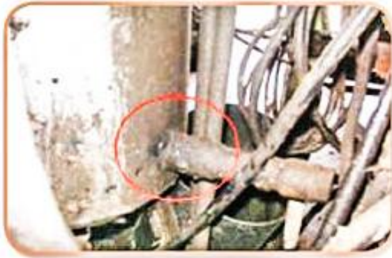
รูปที่ 2-29 รูปแสดงตัวอย่างบริเวณที่มีการรั่วไหลของอากาศอัดก่อนและหลังปรับปรุง
