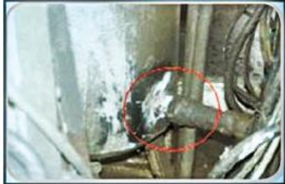
รูปที่ 2-29 รูปแสดงตัวอย่างบริเวณที่มีการรั่วไหลของอากาศอัดก่อนและหลังปรับปรุง
