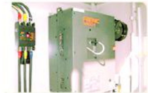
รูปหลังการปรับปรุง ติดตั้งอุปกรณ์ควบคุมความเร็วรอบ
