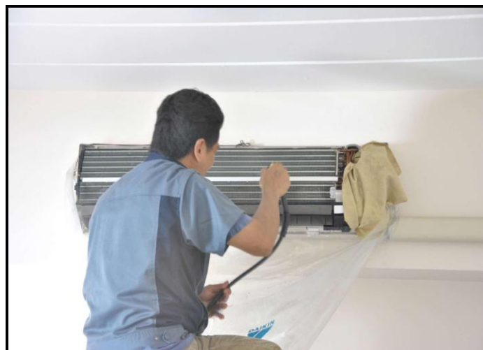
รูปที่ 13-42 ขั้นตอนการล้างชุดแฟนคอยล์
