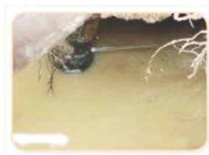
รูปแสดงก่อนการปรับปรุง
