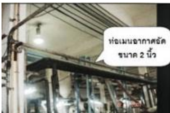
รูปแสดงก่อนการปรับปรุง
