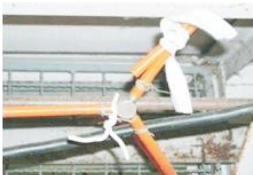
รูปแสดงก่อนการปรับปรุง
