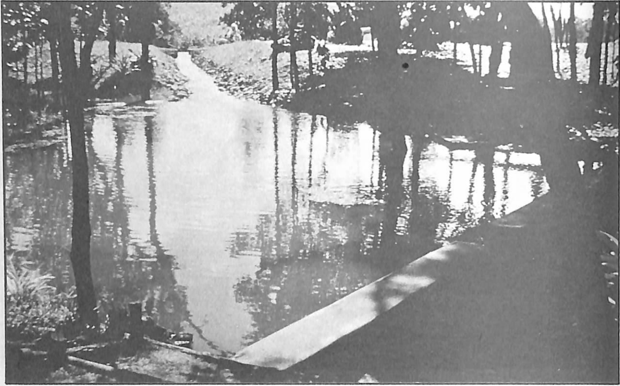
จุดปลายท่อพักน้ำ ในศูนย์ห้วยฮ่องไคร้
