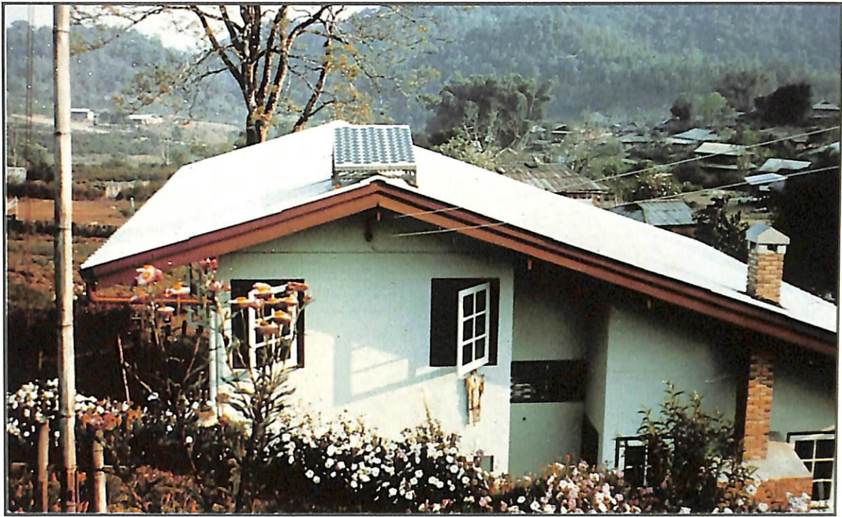
เซลล์แสงอาทิตย์ผลิตไฟฟ้าขนาด ๑๐๐ W สำหรับวิทยุสื่อสารของโครงการหลวงปางอุ๋ง อำเภอ แม่แจ่ม จังหวัดเชียงใหม่
